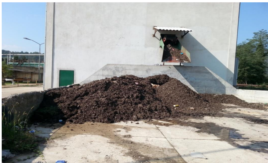
Slika 6. Odloženi mulj poslije filter prese koji se transportuje na spaljivanje
