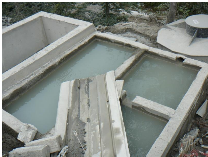
Slika 1. Sistem za prečišćavanje otpadnih voda iz tunela
