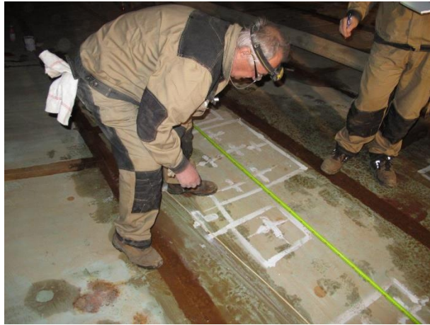
Slika 5. Obeležavanje mesta za sanaciju nakon završenog MFL ispitivanja
