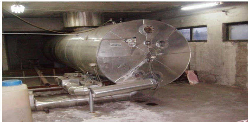
Slika 5. Spremnik napojne vode sa otplinjačem u posmatranom pogonu
