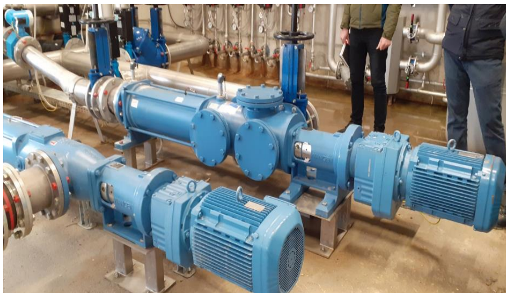
Slika 2. Glavne vijčane pumpe za transport supstrata
