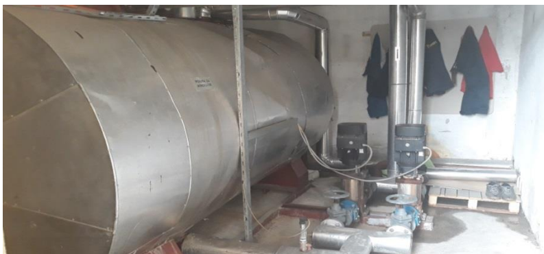
Slika 3. Spremnik kondenzata u posmatranom pogonu
