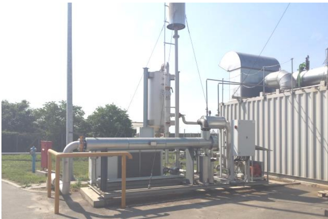
Slika 10. Sistem za obradu bioplina i baklja za spaljivanje bioplina
