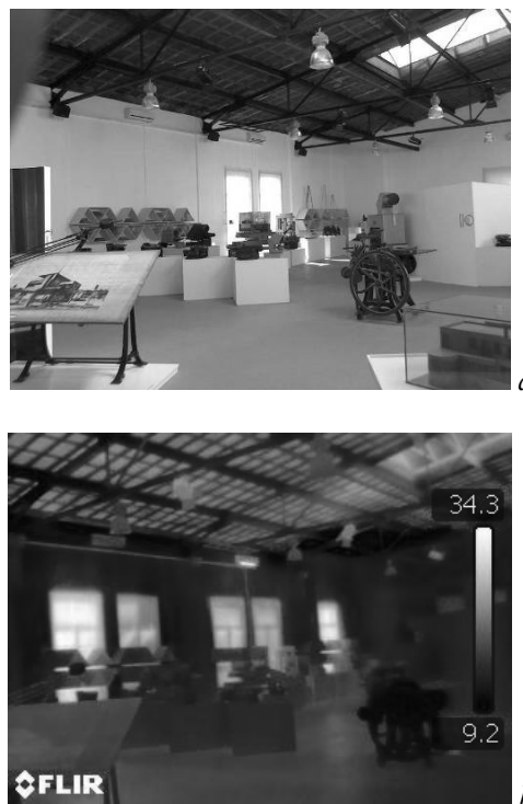
Slika 4. Skrivena struktura zida izložbenog prostora
