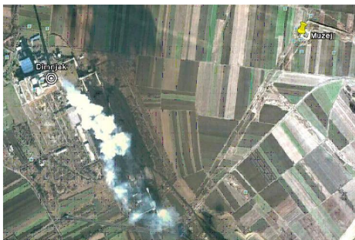
Slika 1. Mapa terena oko termoelektrane Kostolac B sa objektima: dimnjak termoelektrane i muzej Viminacijum, pogled odozgo [Google mapa]
