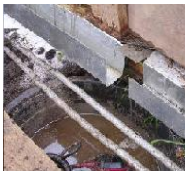
Slika 4.5. Sistem oluka za sakupljanje procedne tečnosti
