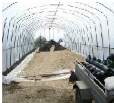
Slika 4.2. Postavljanje cevi za aeraciju
